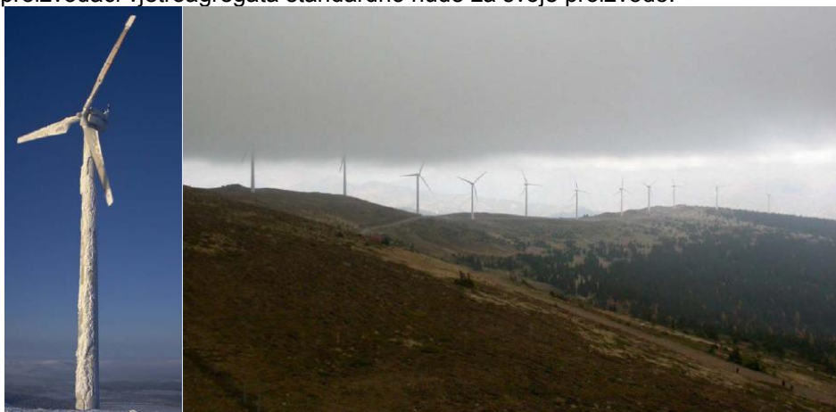
Slika 3 – Zaleđeni vjetroagregat i prikaz lokacije s vjetroagregatima unutar i izvan oblaka (7)
